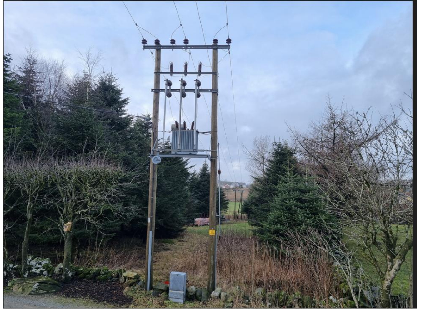
Bilde av den siste mastetrafoen i Klepp, som blei demontert i februar 2024 – etter at ny betongkiosk erstatta denne.
