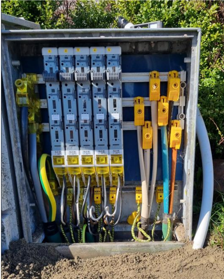
Kabelen heilt til høgre i skapet er ein 3x150-Al TFSP m/red. skjerm (12-14mm 2 )
